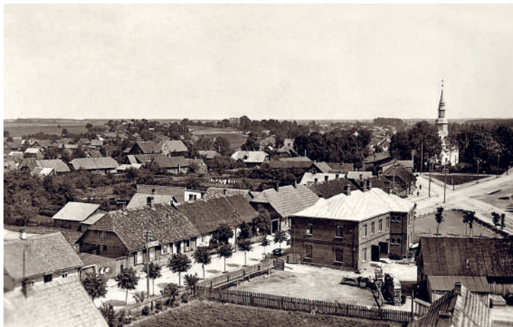
Ap 1930 Fotografēts no Tautas (tagadējā kultūras) nama jumta Dārziņa ielā 8
